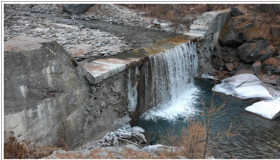
Figura 1.4: Briglia di consolidamento B02; si notino i segni di ammaloramento sul paramento di valle
