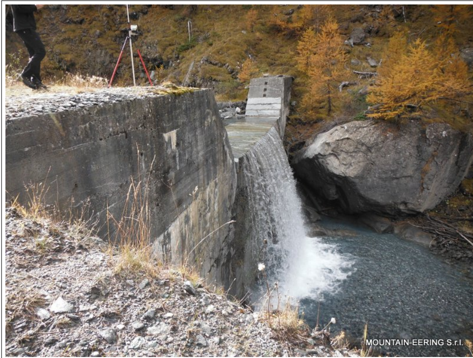
Figura 1.7: Briglia di consolidamento B05; si notino i segni di ammaloramento sul paramento di valle
