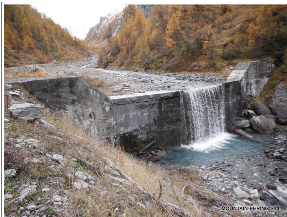
Figura 1.10: Briglia di consolidamento B08
