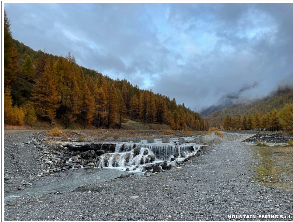
Figura 1.3: Soglia in massi cementati in superficie a lato del bacino in località Pattemouche
