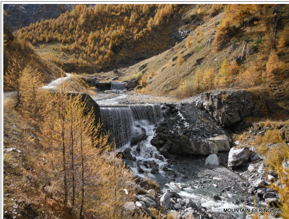
Figura 1.8: Briglia di consolidamento B06, crollata durante lavori di manutenzione
